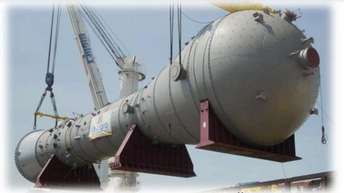
Реактор полимеризации, массой 431 тонн
