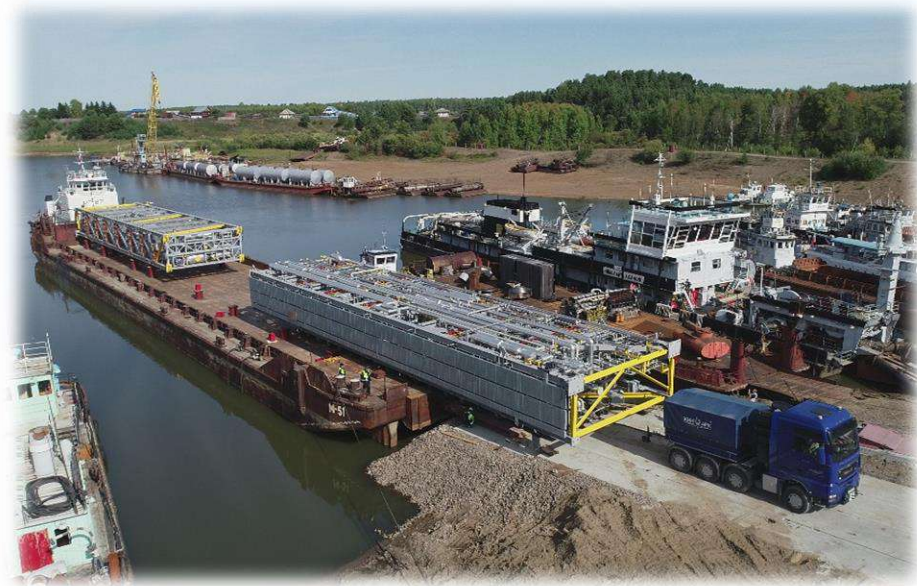
Процесс выгрузки Ро-Ро способом модулей на временное причальное сооружение
