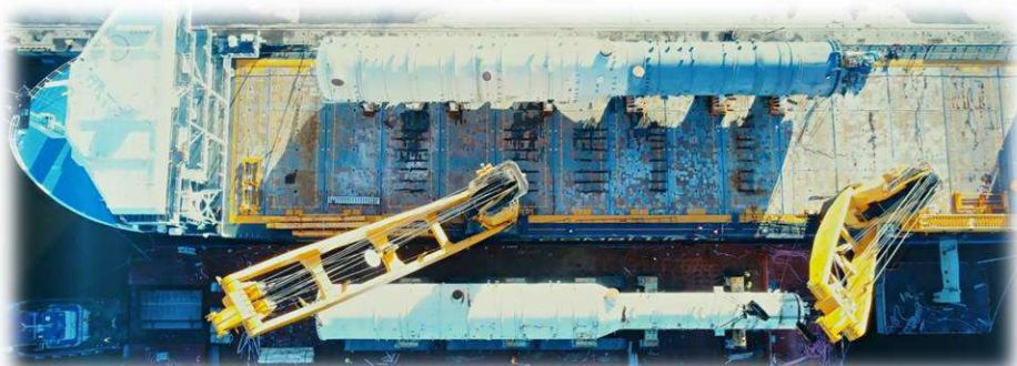
Перегрузка колонны с кранового судна на баржу
