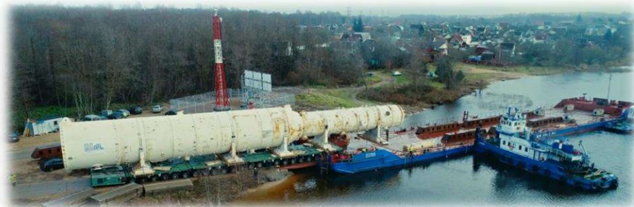
Процесс выгрузки Ро-Ро способом колонны на временное причальное сооружение
