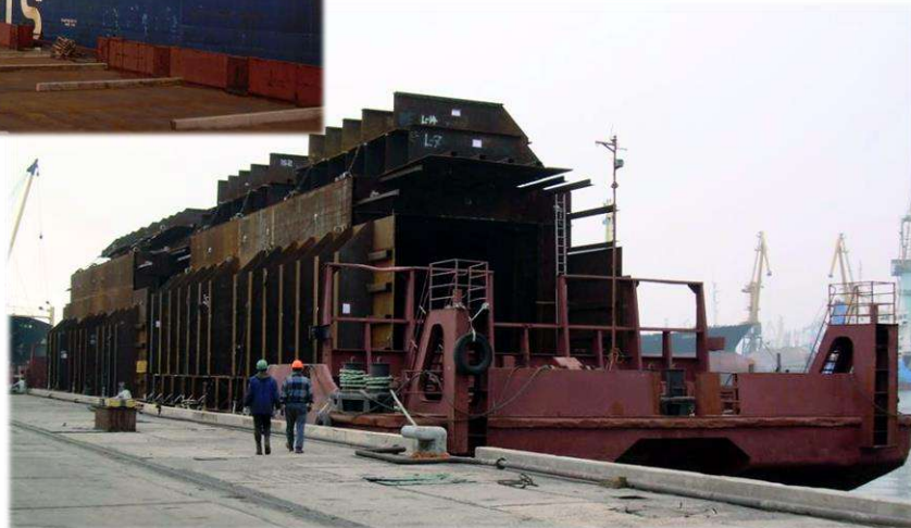
Перегрузка металлоконструкций с т/х Veluga Intonation, 2008
