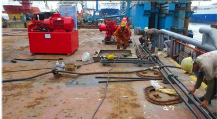
Подготовка транзитной баржи
