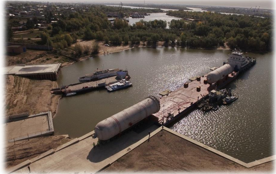
Процесс выгрузки накатным способом коксовых камер на причал Омского НПЗ
