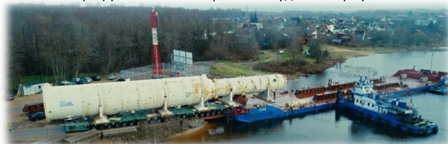
Процесс выгрузки накатным способом колонны на временное причальное сооружение
