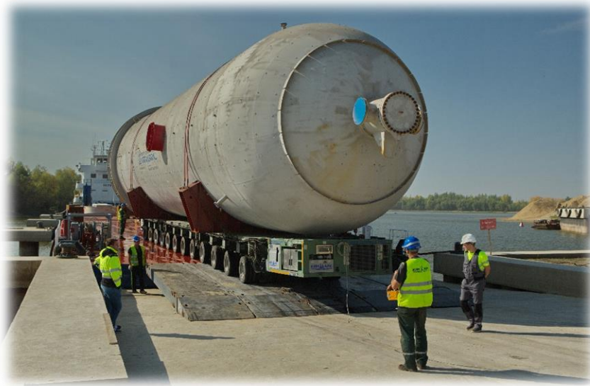
Процесс выгрузки накатным способом коксовых камер на причал Омского НПЗ
