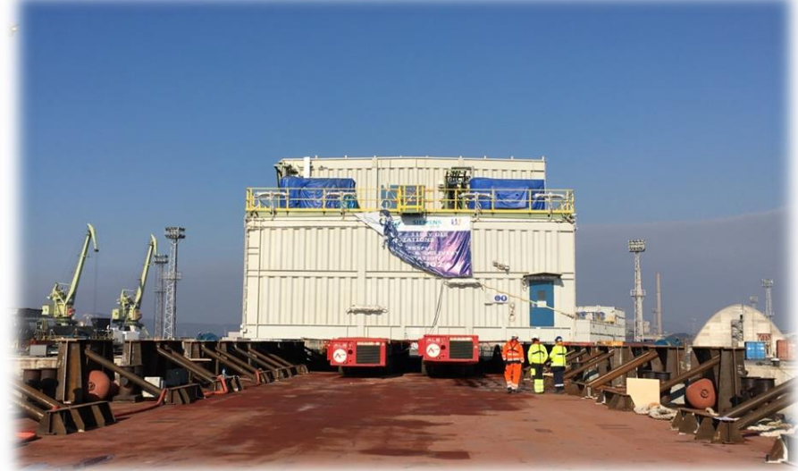
Процесс погрузки накатным способом модуля массой 1100 тонн на баржу
