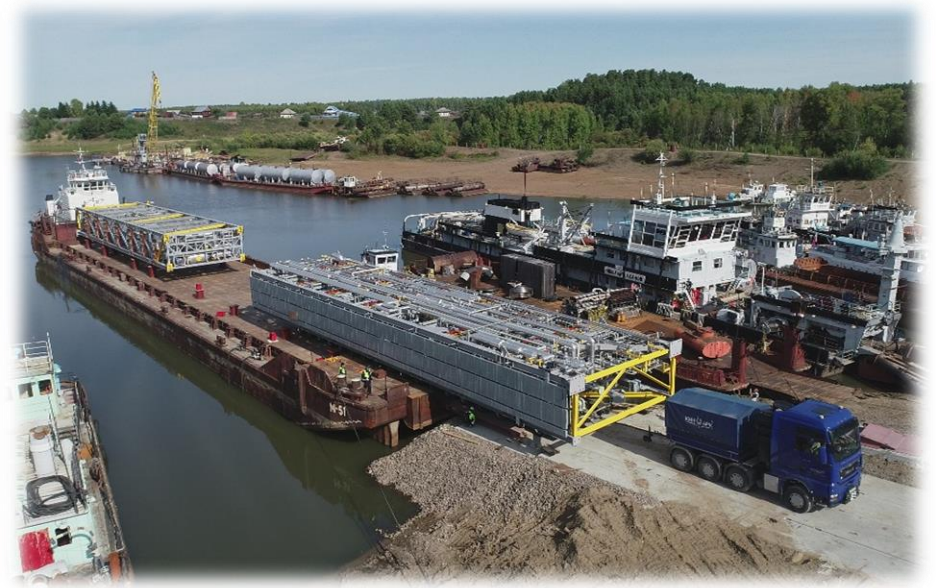
Процесс выгрузки накатным способом модулей на временное причальное сооружение
