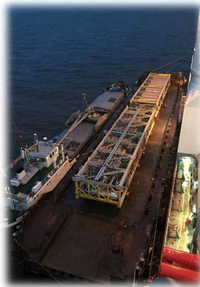
Перегрузка модулей с кранового судна на баржу
