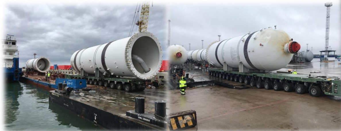
Перегрузка с речной баржи на баржу «DRS 3». Выгрузка с баржи «DRS 3» в порту Усть-Луга Адсорбционная колонна, масса 235 тонн
