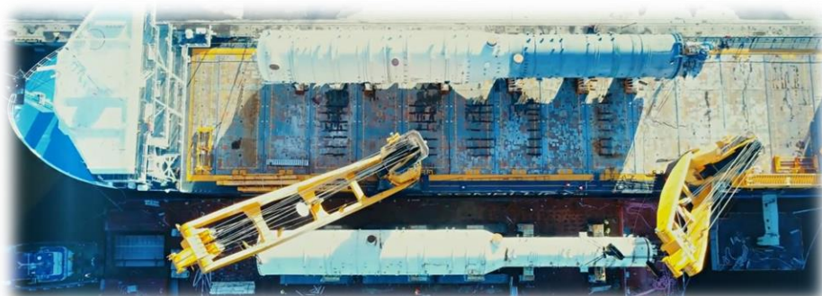
Перегрузка колонны с кранового судна на баржу
